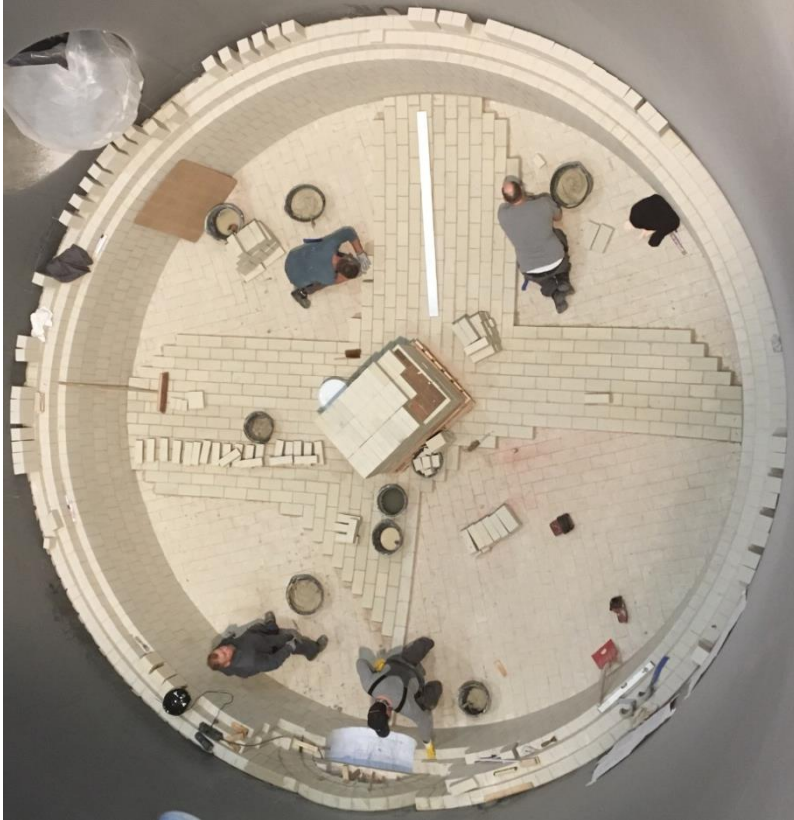
Stahlkonstruktion, ausgemauert (säure-/hitze-beständig)
