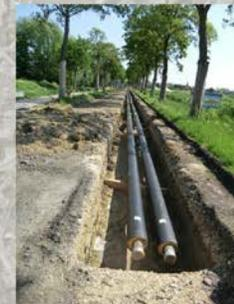
In einer Rohrleitung wird mit Heizwasser die Wärme von der Heizzentrale zum Endkunden transportiert.
