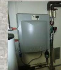
Die Wärme aus den Rohrleitungen wird hier mittels eines Wärmetauschers in die Hausinstallation übertragen. Diese Anlage ersetzt den Heizungskessel. Die abgenommene Wärme wird mit einem geeichten Wärmemengenzähler ermittelt.
