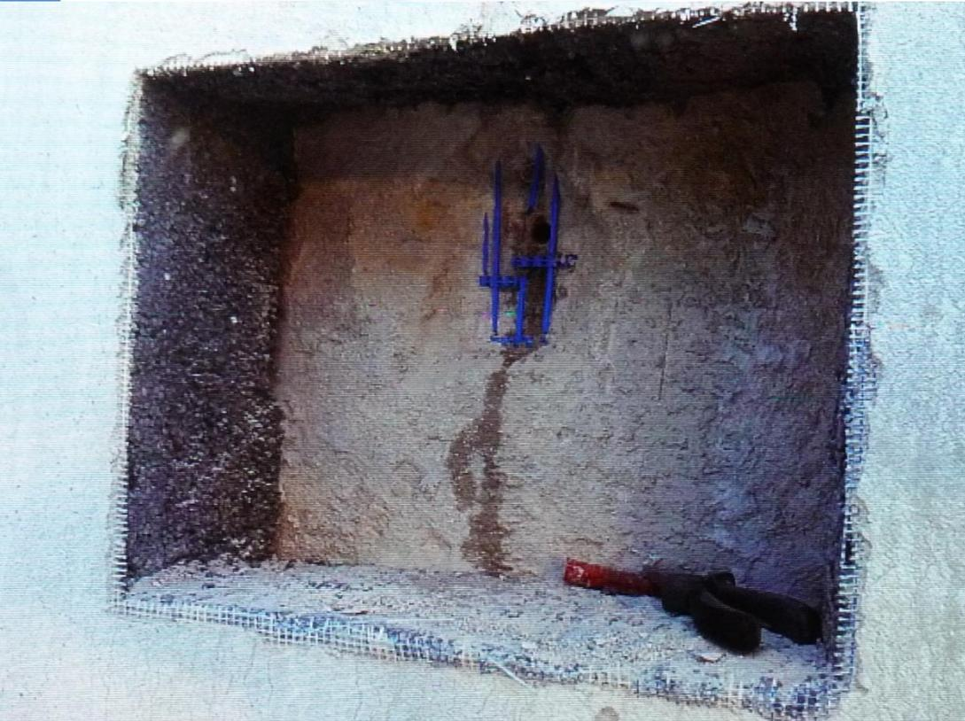
Zerstörung einer Kapillare
