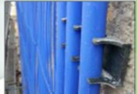
**Clipschiene** zur Befestigung mehrerer Stammrohre
