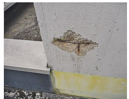
Bild 5. Schadstellen auf der Westfassade des Gebäudes (Fotos entnommen aus Gutachten der WPM-Ingenieure GmbH) Fig. 5. The damaged areas on the west façade of the building (Source: expert's report by WPM-Ingenieure GmbH)
