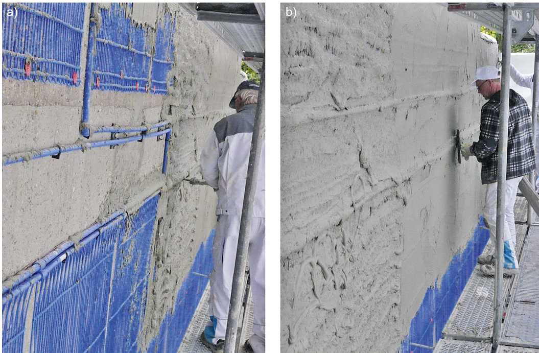
Bild 10. Maschinelles Aufbringen des Unterputzes auf die Kapillarrohrmatten (a) und manuelles Glattstreichen der Putzschicht (b) Fig. 10. Machine application of the plaster to the capillary tube mats (a) and manual smoothing of the plaster layer (b)
