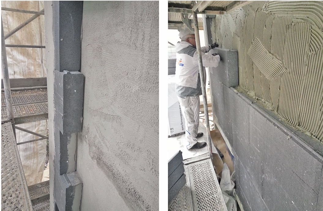
Bild 12. Installation der Wärmedämmplatten aus EPS mittels vollflächiger Verklebung Fig. 12. Installation of EPS thermal insulation panels by means of full-surface bonding
