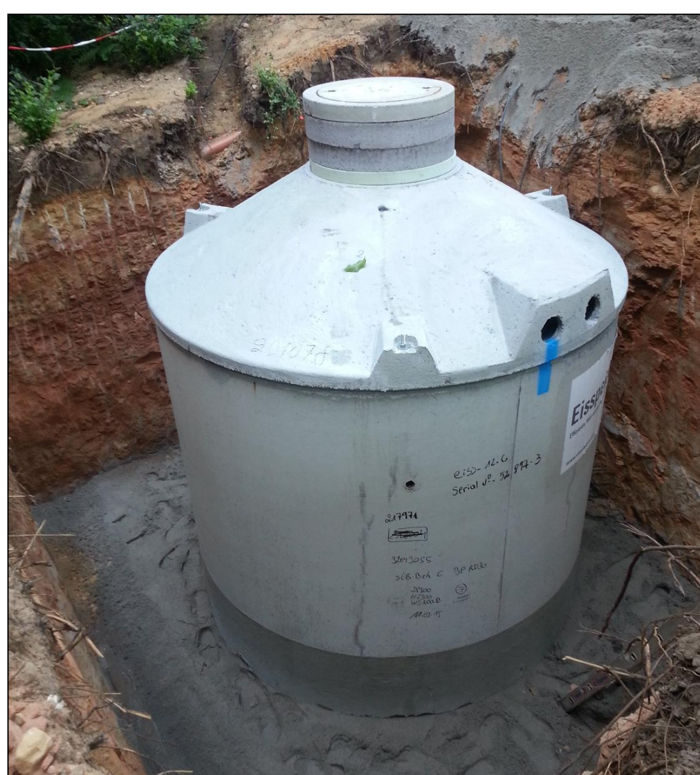
Abbildung 1: Eisspeicher in der unverfüllten Baugrube neben dem Gebäude
