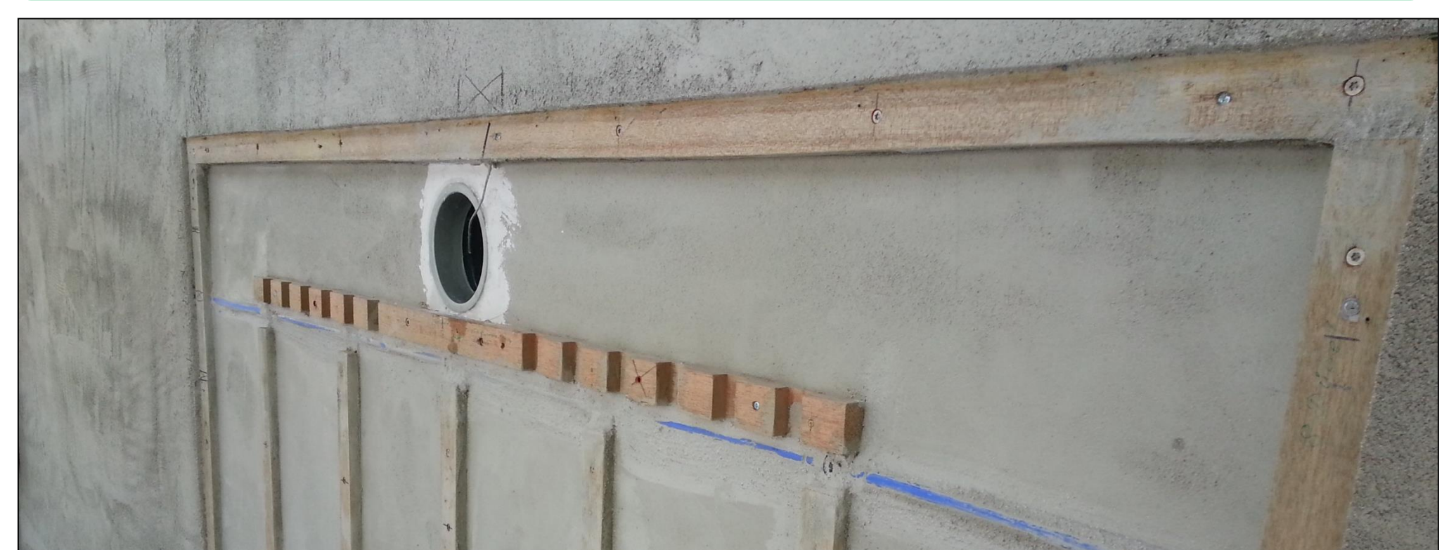
Abbildung 4: Umsetzung der außenliegenden Lufttemperierung an der Fassade. Zu erkennen ist der geöffnete Luftkollektor inkl. Rahmen, Abstandshalter und Kernbohrung
