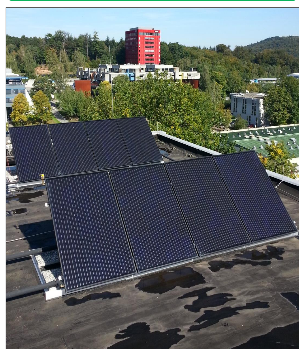
Abbildung 2: PVT-Kollektoren auf dem Dach des Gebäudes
