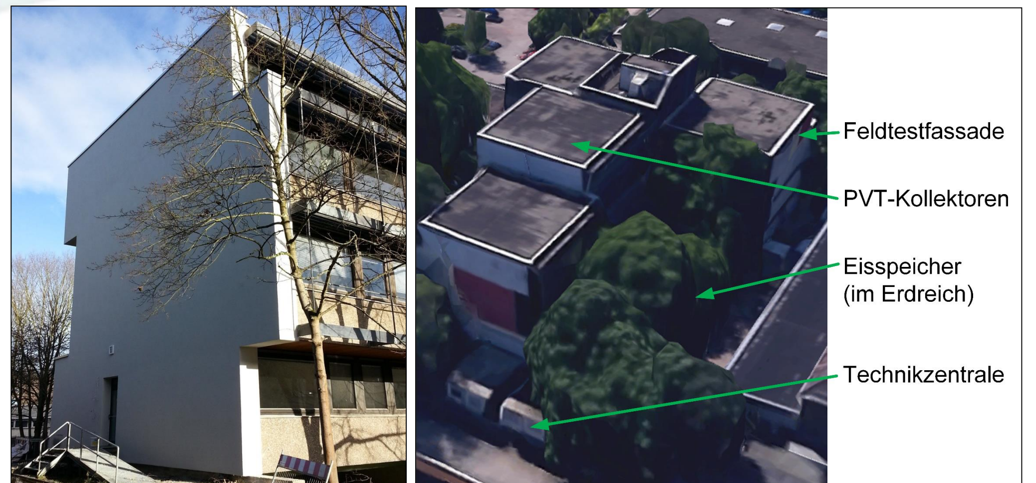
Abbildung 3: Foto der sanierten Feldtestfassade (links) und Luftbild des Gebäudes von Norden mit Markierung der Lage der Komponenten (rechts). [Quelle: Google Maps]
