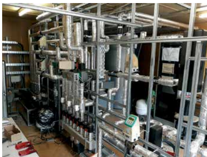
Abbildung 5: Dach mit den PVT-Hybridkollektoren (oben links) Foto der PVT-Kollektoren von hinten mit Aufständigung und Beschwerung (oben rechts). Eisspeicher in der unverfüllten Baugrube (Mitte links). Baufeld mit Eisspeicher nach der Verfüllung, zu sehen ist nur noch der Elektro-Verteilerkasten (Mitte rechts). Technikzentrale im Bauzustand mit ankommenden Erdleitungen, Wärmepumpe und Pufferspeicher (unten links). Blick in die Technikzentrale mit der Hydraulik-Verteilung und MSR-Technik (unten rechts).
