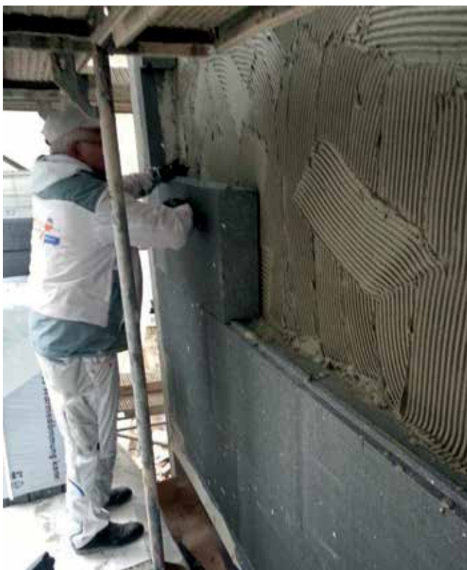
Abbildung 4: Fassade im Ausgangszustand, Fassade mit Kapillarrohrmatten der Wandtemperierung, Einputzen der Matten, Aufkleben der Wärmedämmung, Armierung und Fassade im sanierten Zustand
