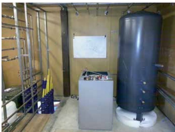
Abbildung 5: Dach mit den PVT-Hybridkollektoren (oben links) Foto der PVT-Kollektoren von hinten mit Aufständigung und Beschwerung (oben rechts). Eisspeicher in der unverfüllten Baugrube (Mitte links). Baufeld mit Eisspeicher nach der Verfüllung, zu sehen ist nur noch der Elektro-Verteilerkasten (Mitte rechts). Technikzentrale im Bauzustand mit ankommenden Erdleitungen, Wärmepumpe und Pufferspeicher (unten links). Blick in die Technikzentrale mit der Hydraulik-Verteilung und MSR-Technik (unten rechts).
