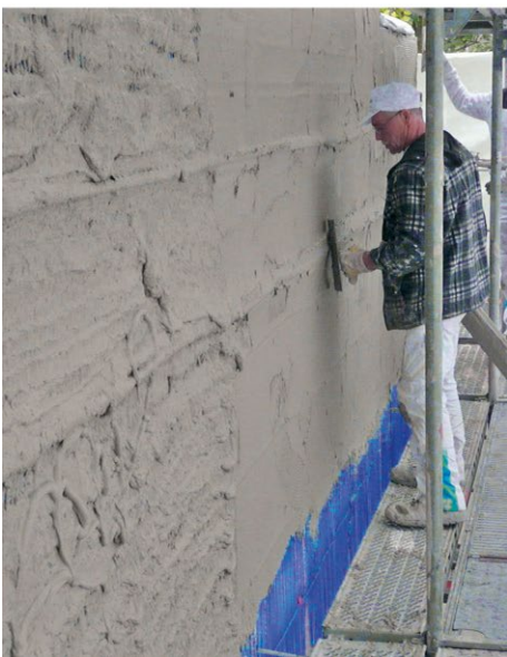
Bild 9. Einputzen der Kapillarrohrmatten mit Klebemörtel (oben) und Glattziehen desselbigen auf der Fassade des Demonstrators (unten)
