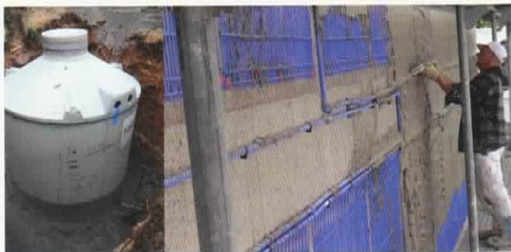
Eisspeicher mit 10 m<sup>3</sup> / Die Kapillarrohmatten werden mit Klebemörtel eingeputzt
