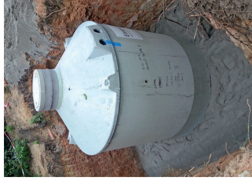
Ausschaltung mit Eisspeicher, unvernüllt.
