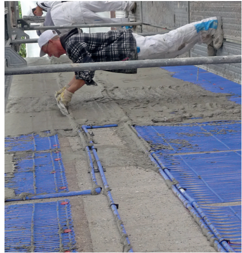
Bei einem Sanierungsprojekt kann nun erstmals eine Flächenheizung außen unter einer Dämmung angebracht werden. Die Kapillarrohrmatten (im Bild) werden dabei auf die Betonfassade aufgebracht und mit Klebmittel eingeputzt.
