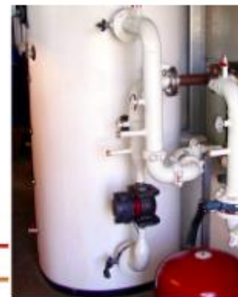
DL | Abwärmennutzung Sauerstoffreduktionsanlage
