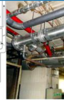
PW | Abwärmennutzung aus der Reifenkochung
