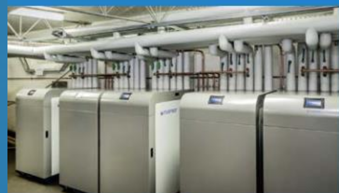
Adsorptionskältemaschinen
