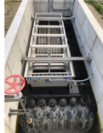
Abwasserwärmetauscher
