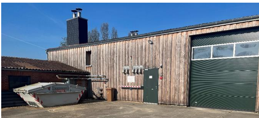
Abbildung 8: Heizhaus der HanseWerk Natur
