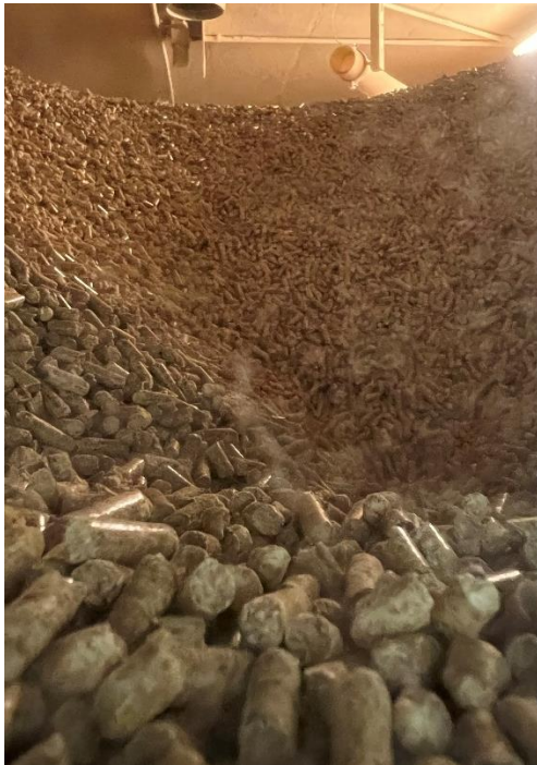
Abbildung 11: Blick in den Pelletbunker im Heizhaus Schönberg; Quelle Müller Rüster
