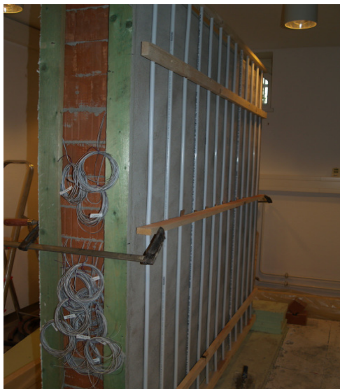
Abbildung 11: Wand mit „Altputz“ und darauf fixierten PEX-Heizungsrohren
