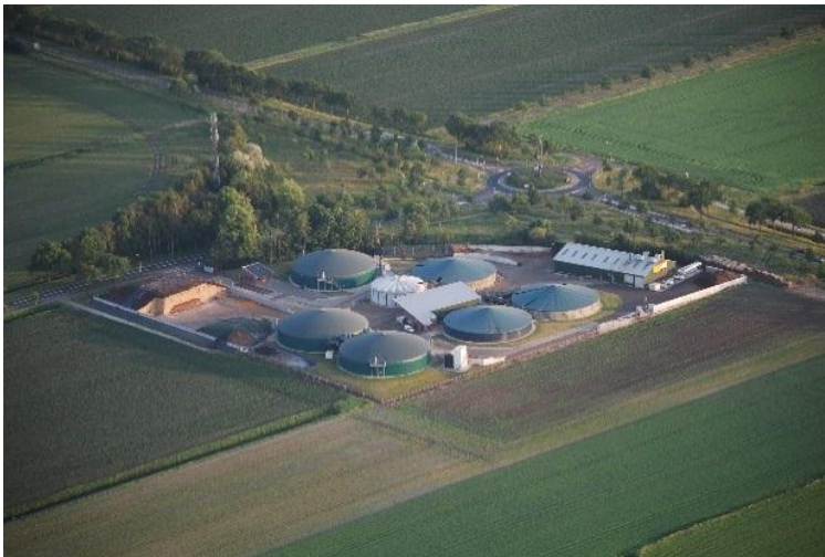
Abbildung 13 Anaerobe Vergärungsanlage Jansen Wijhe, Groningen 17
