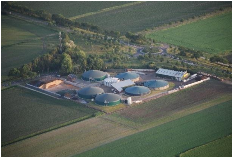
Abbildung 11 Anaerobe Vergärungsanlage Jansen Wijhe, Groningen 17
