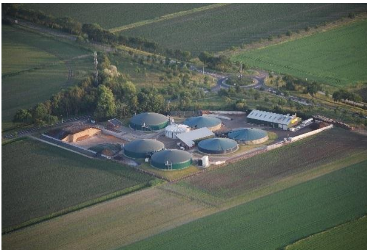
Abbildung 13 Anaerobe Vergärungsanlage Jansen Wijhe, Groningen 17
