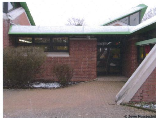
Betrachtung von außen
