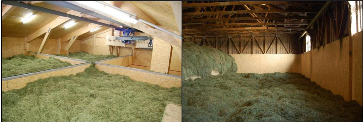
Abbildung 2: Unterschiedliche bauliche Varianten der Boxentrocknung. Links: Drei Kammern mit Heukran, rechts: Zwei Kammern mit unterschiedlichen Füllstand. (Bild: M. Kittl, Landwirtschaftskammer Salzburg, ARGE Heumilch Österreich)
