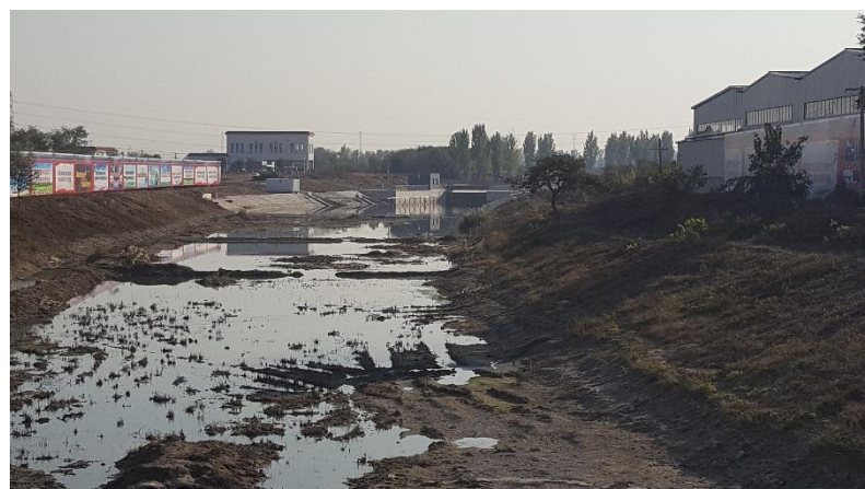
Situation vor Ort
