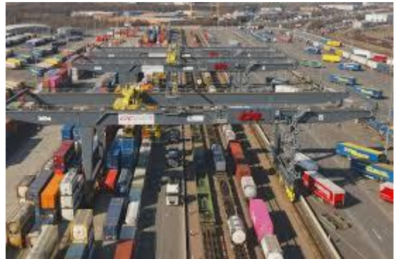
CFL multimodal Bettembourg
