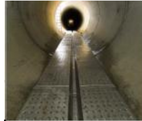
Fig. 4 Heat Exchanger Wahn @Rheinenergie
