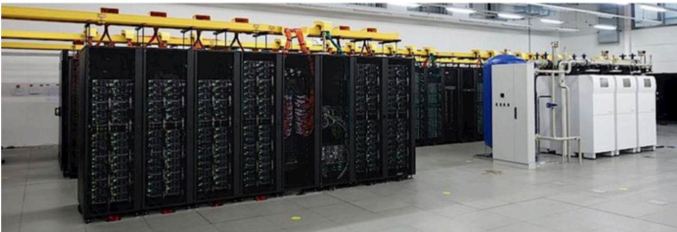
Beim Rechen-Cluster CoolMUC-2 sorgen sechs Adsorptionskältemaschinen von Sortech dafür, dass die beim Rechnen erzeugte Abwärme zur Kälteproduktion verwendet wird.
