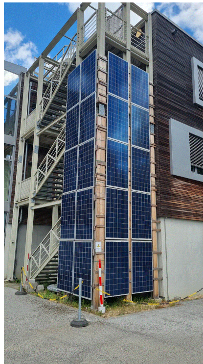
Abbildung 2: PV-Module in ein innenliegendes Geländer integriert (links), PV-Module an einer Außen-Treppe (rechts)
