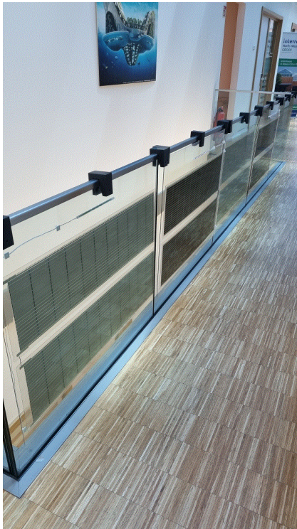
Abbildung 2: PV-Module in ein innenliegendes Geländer integriert (links), PV-Module an einer Außen-Treppe (rechts)
