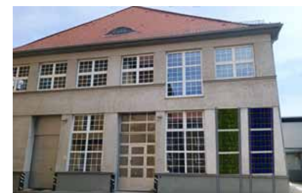
VertiKKA-Projektion an der Fassade des Technikums des Bauhaus-Institutes für zukunftsweisende Infrastruktursysteme (b.is) (Quelle: Sara Wullenkord, BUW)
