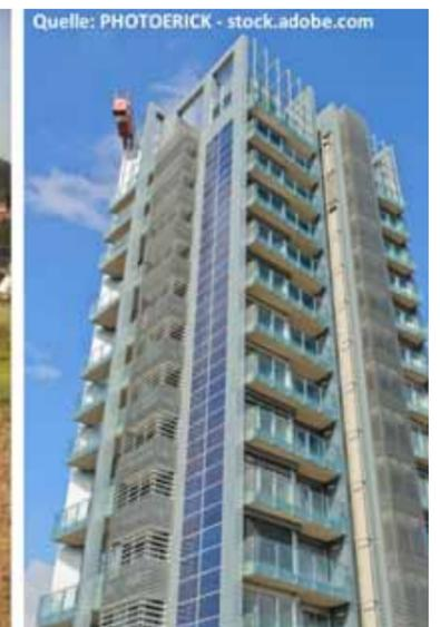
In Fassade integrierte PV-Elemente
