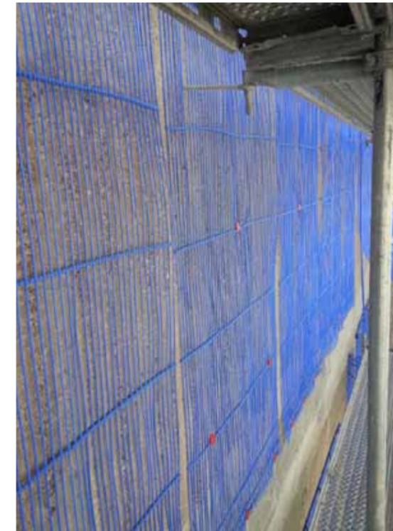
Fassade mit Kapillarrohrmatten
